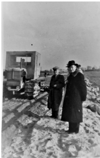
在波兰工地勘察
